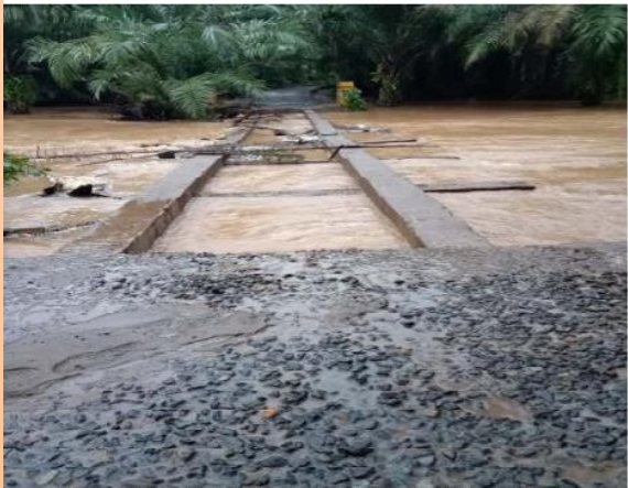
JEMBATAN PENGHUBUNG DESA GENTING DABUK DENGAN TANJUNG KEPAHYANG KEC. PEMATANG TIGA
